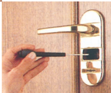
Com uma chave de fendas, desapertar os dois parafusos que fixam o segredo
